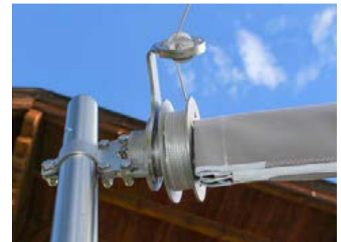
Zugseil 4 mm Dyneema mit Seileinführung und Seiltrommel
