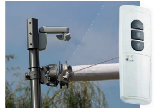
Windwächter auf Säule und Motorzuleitung
